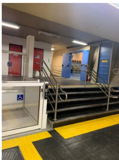
Instalação de plataforma para cadeirantes no Auditório – piso superior (2020-2021).
