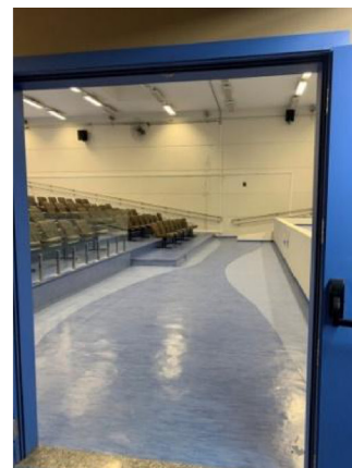
Troca do piso do auditório e ajuste da largura do distanciamento dos corredores, instalação de corrimão e locais para cadeirantes e obesos, segundo o Projeto de acessibilidade e incêndio.
