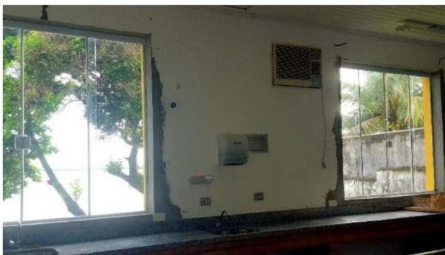
Troca das janelas dos laboratórios e modificação do ângulo do muro de entrada para facilitar acesso dos ônibus com os alunos. Janeiro de 2018.
