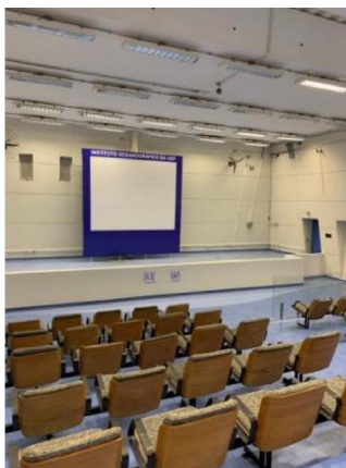
Troca do piso do auditório e ajuste da largura do distanciamento dos corredores, instalação de corrimão e locais para cadeirantes e obesos, segundo o Projeto de acessibilidade e incêndio.
