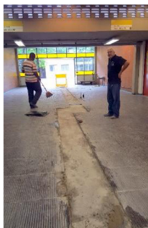
Substituição de canos de ferro por PVC, correção de vazamentos no Salão Azul e acidentes na laje.
